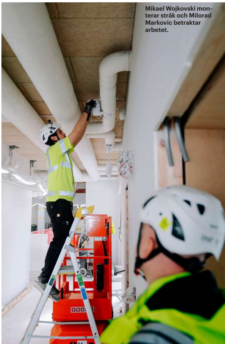
Instair har tagit fram egna återanvändbara kanalskydd, som ersätter engångsplast.
